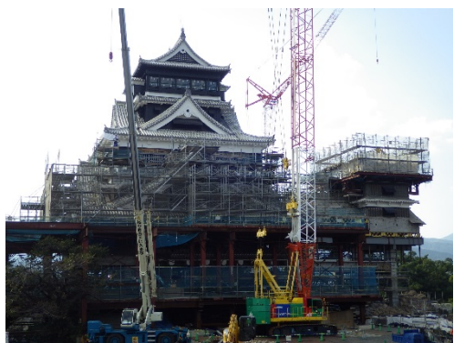
熊本城の復旧。全国から多くの寄附金が寄せられ、順調に工事が進む。
