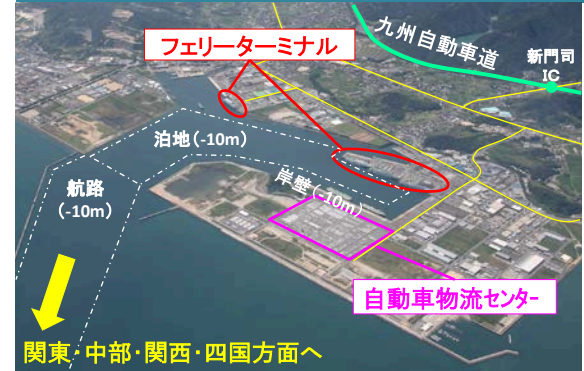
提供)九州地方整備局
