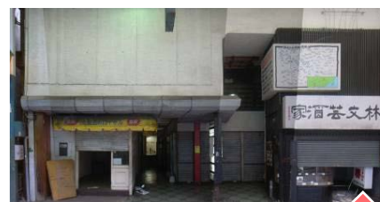
空き店舗(改装前)
