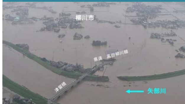
矢部川水系矢部川直轄河川激甚災害特別緊急事業(事例)
