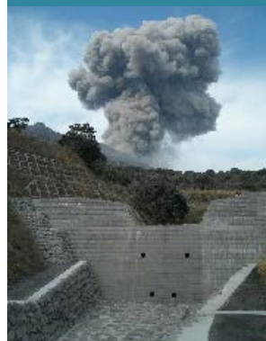
砂防堰堤の整備(事例)
