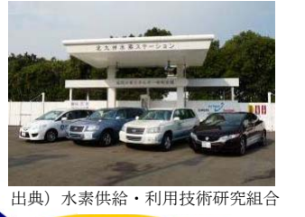
＜水素ステーションの整備＞
