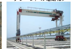
提供) 九州地方整備局
