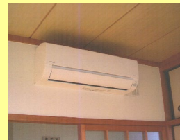
休憩室にエアコン設置 (大町町)
