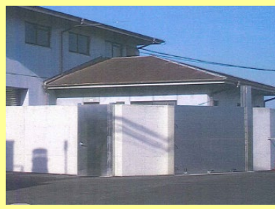
止水壁の設置(大町町)
