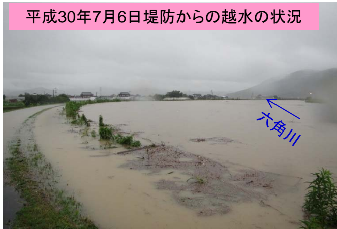
▲ 武雄市橘町(六角川左岸28k800付近)
