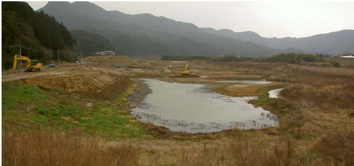
改良工事中の下池（平成 18 年 2 月 7 日）
