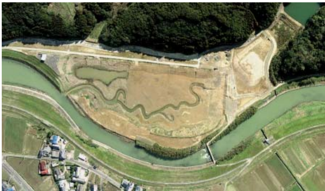
アザメの瀬の二次掘削完了後の状況（平成 17 年 3 月）
