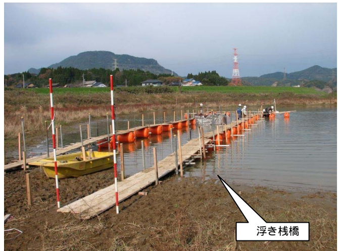
浮き栈橋の設置（平成 18 年 12 月 5 日）
