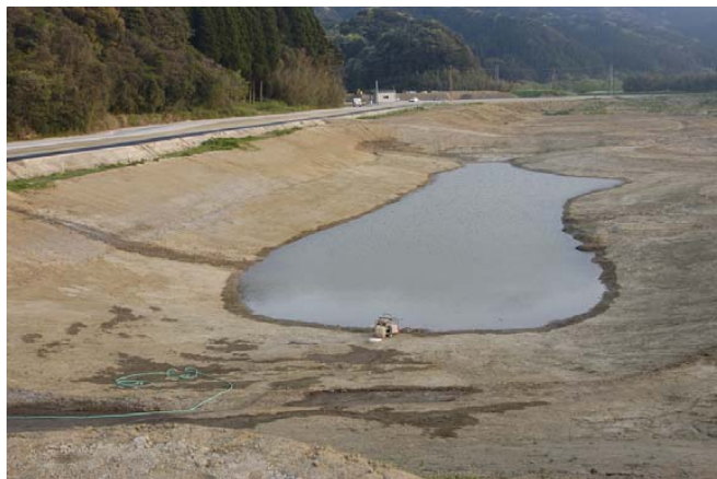
掘削直後の下池（平成 16 年 4 月 14 日）
