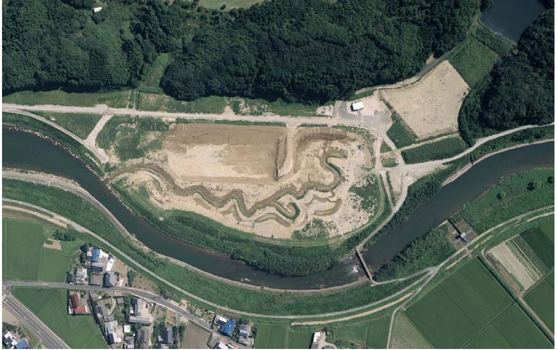
アザメの瀬のクリーク掘削中の状況（平成 15 年 9 月）
