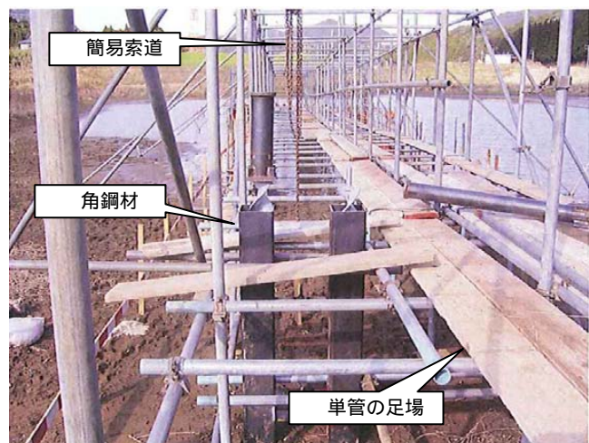
単管の足場・索道・角鋼管による工夫（平成 19 年 1 月）
