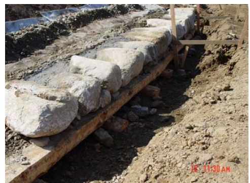
石積みの設置（平成18年1月12日）
