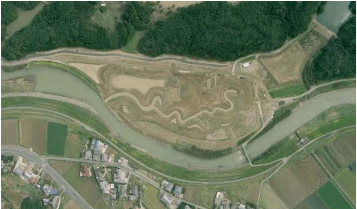
アザメの瀬の一次掘削完了後の状況（平成 16 年 3 月）
