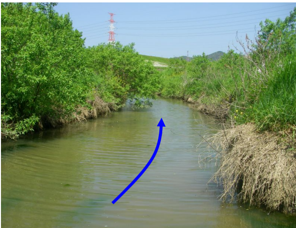
クリーク下流側の河岸の状況(木柵無し)
