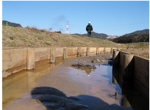
板柵工の施工状況(平成18年2月13日)
