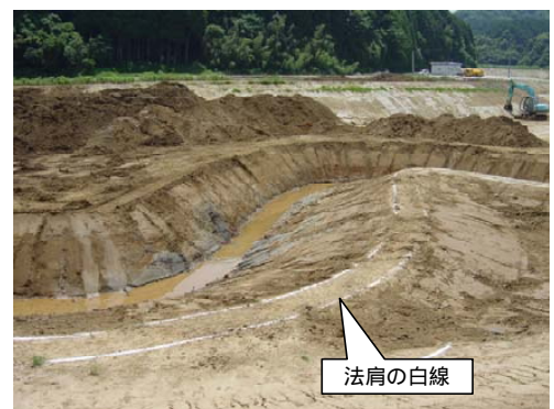
白線を引いて手探りでクリークを掘削
