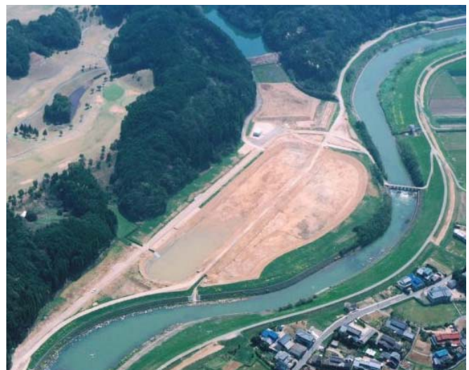
一次掘削後のアザメの瀬（平成 15 年 5 月 21 日）
