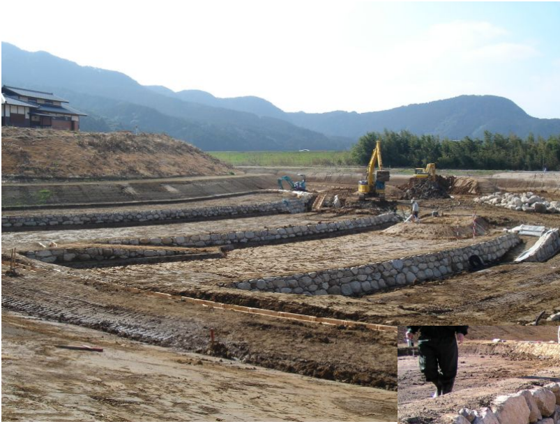
棚田の工事状況（平成 18 年 2 月 2 日）
