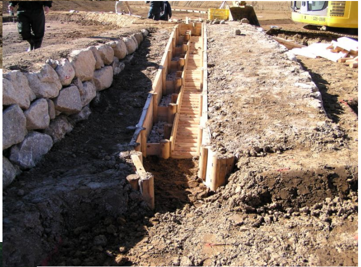
水田魚道の工事状況（平成 18 年 2 月 2 日）
