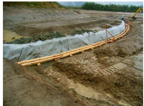
基礎の設置完了（平成17年12月23日）
