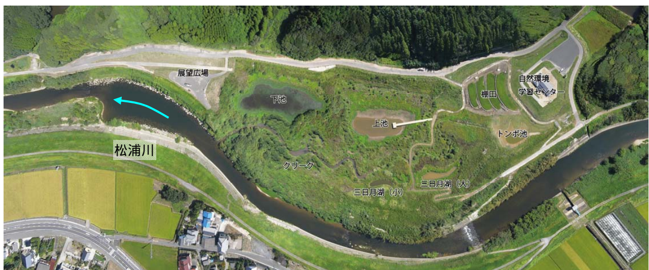
図 1-10 アザメの瀬地区の工事完了後の状況（平成 21 年 10 月撮影）
