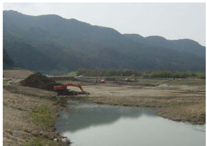
掘削中の上池予定地（平成 17 年 2 月 23 日）
