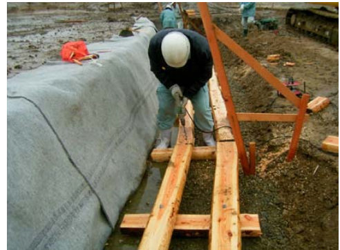
梯子土台の設置（平成17年12月23日）
