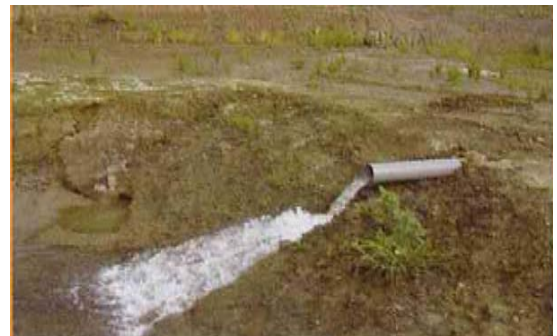
ため池からクリークへの導水
