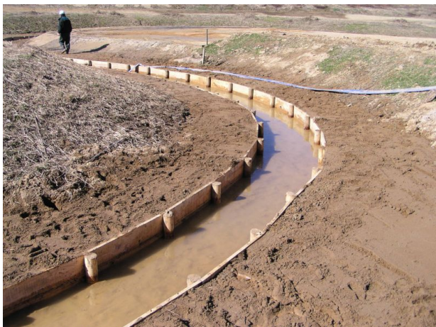
クリーク改良工事の状況（平成 18 年 2 月 13 日）
