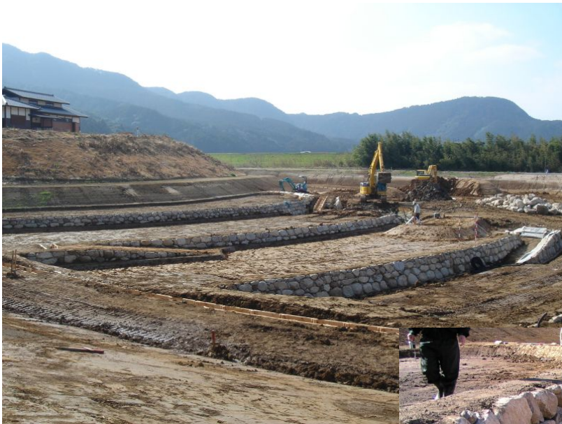
棚田の工事状況（平成 18 年 2 月 2 日）
