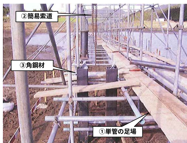
単管の足場・索道・角鋼管による工夫（平成 19 年 1 月）
