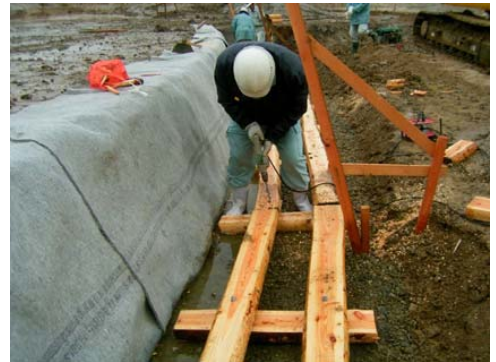
梯子土台の設置（平成 17 年 12 月 23 日）
