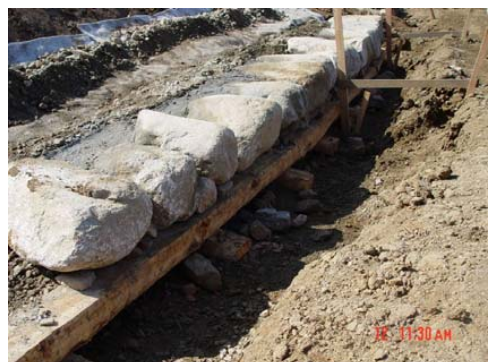
石積みの設置（平成 18 年 1 月 12 日）
