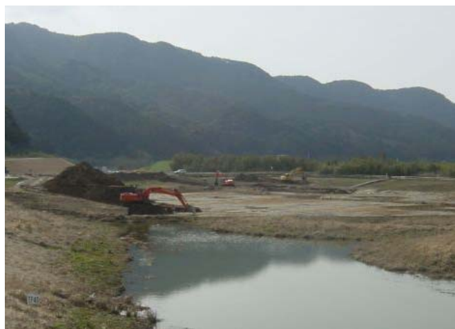
掘削中の上池予定地（平成 17 年 2 月 23 日）
