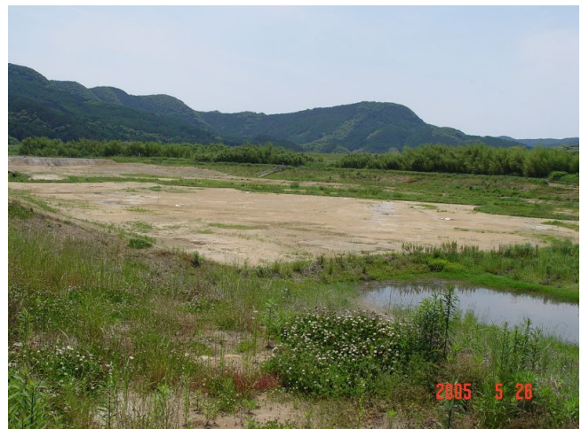
約 3 ヶ月後の上池予定地（平成 17 年 5 月 26 日）
