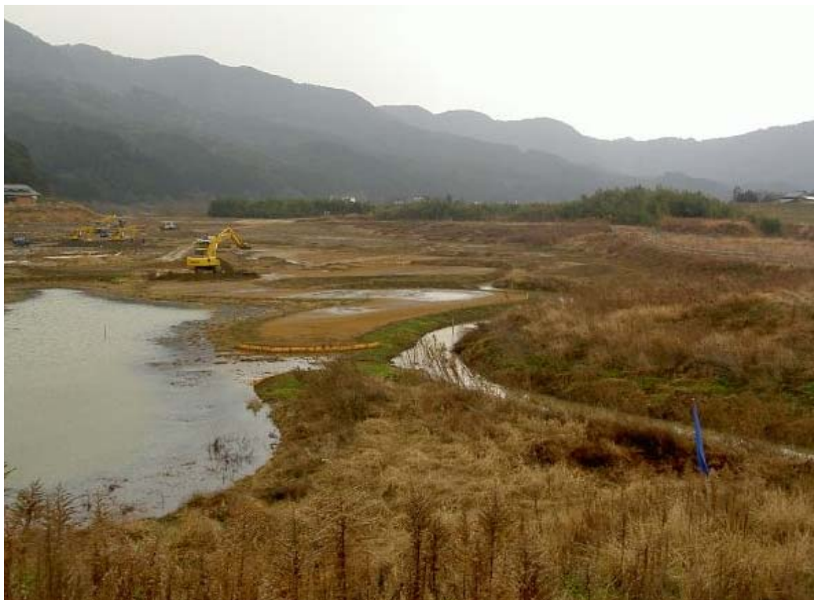
クリーク右岸天端高の切り下げ工事の状況（平成 18 年 2 月 7 日）
