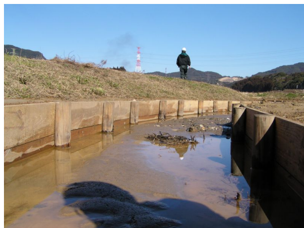
板柵工の施工状況（平成 18 年 2 月 13 日）
