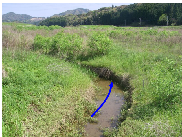
クリーク上流側の河岸の状況（木柵有り）
