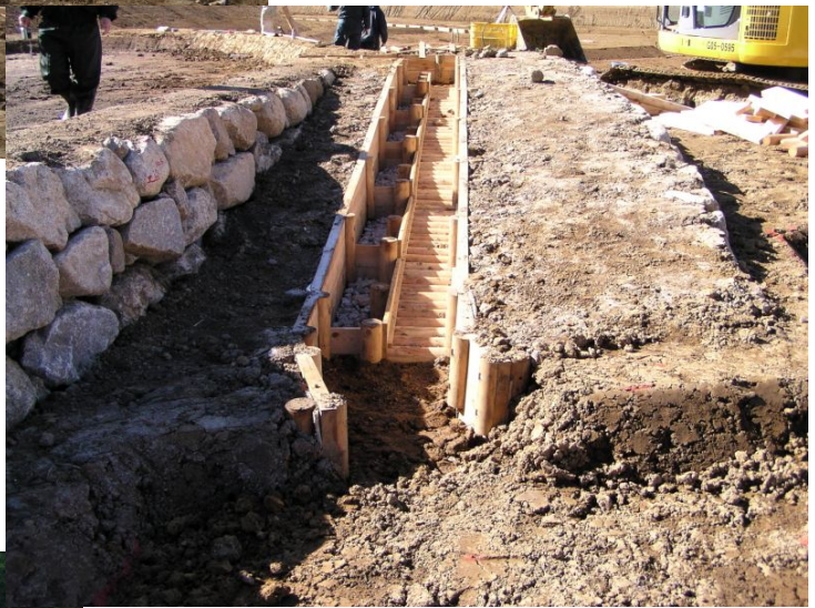
水田魚道の工事状況（平成 18 年 2 月 2 日）
