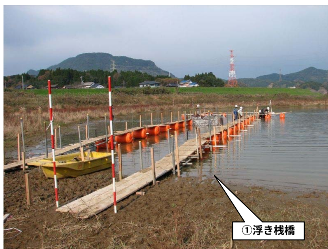
浮き栈橋の設置（平成 18 年 12 月 5 日）
