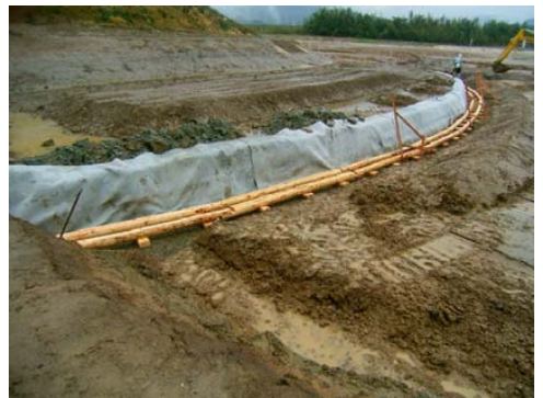
基礎の設置完了（平成 17 年 12 月 23 日）
