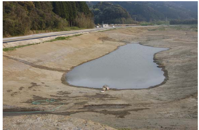
掘削直後の下池（平成 16 年 4 月 14 日）
