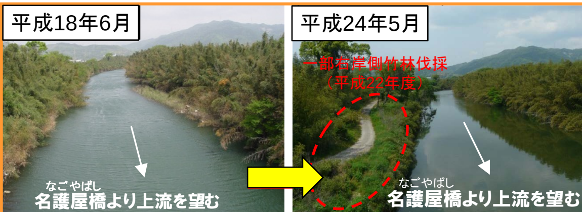
河道内樹木の伐採状況 14k600
