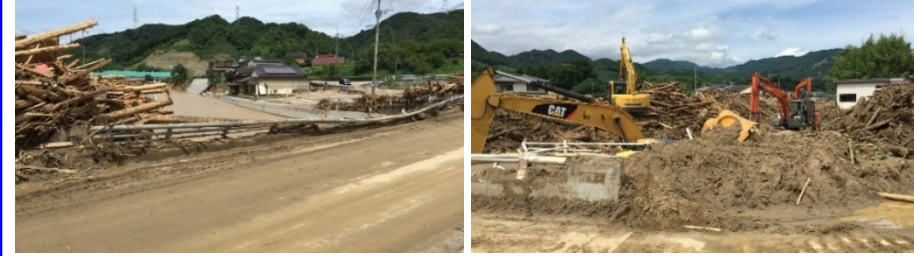
福岡県赤谷川被害状況
