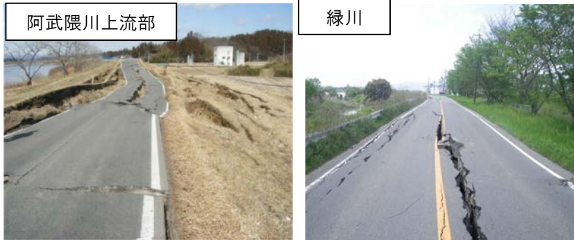
地震による堤防の被災状況
