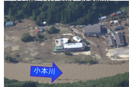
小本川の浸水被害の様子 （平成28年8月 台風10号）
