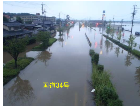
小城市内(国道34号)の冠水状況
