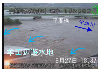
越流状況（越流堤倒伏後）
