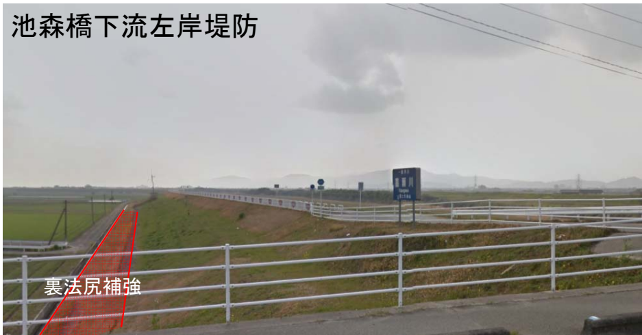
堤防天端をアスファルト舗装等で保護 堤防裏法尻をブロック等で補強
