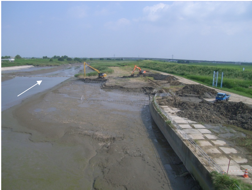
ガタ土掘削状況(嘉瀬川大堰下流)
