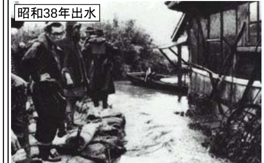
佐賀市内の浸水状況
