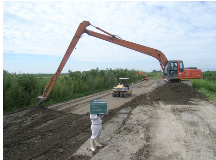
堤防強化対策工事(池ノ上地区)
