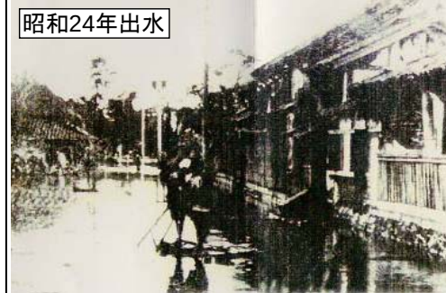
佐賀市池の上地区の浸水状況
