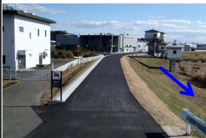
堤防天端対策状況 (六角川赤坂地区：H29.3)
