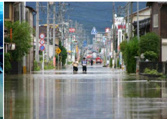
武雄市高橋地区の氾濫状況
