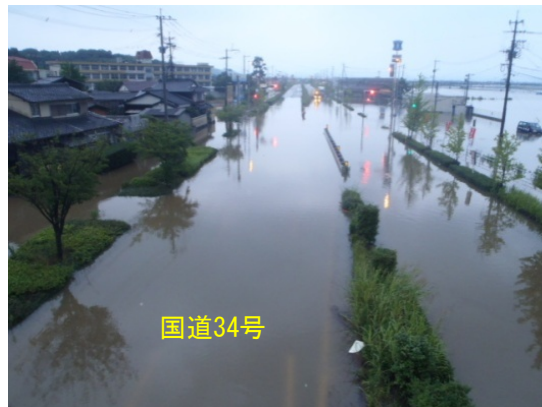
小城市内(国道34号)の冠水状況
