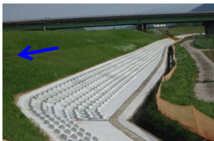
堤防法尻対策状況 (六角川高橋地区：H29.4)
