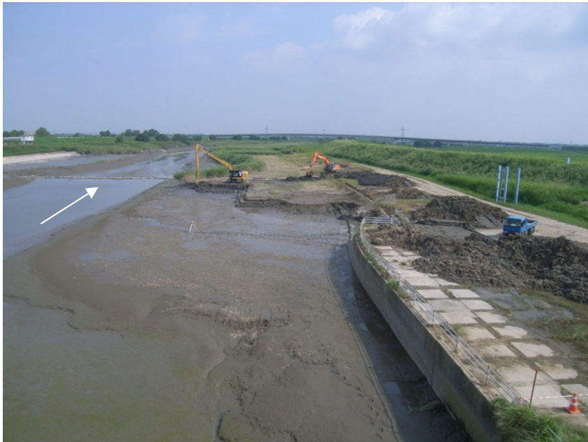
ガタ土掘削状況(嘉瀬川大堰下流)
