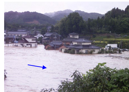
水留橋付近の状況 (徳須恵川 12/600付近：伊万里市南波多町)
