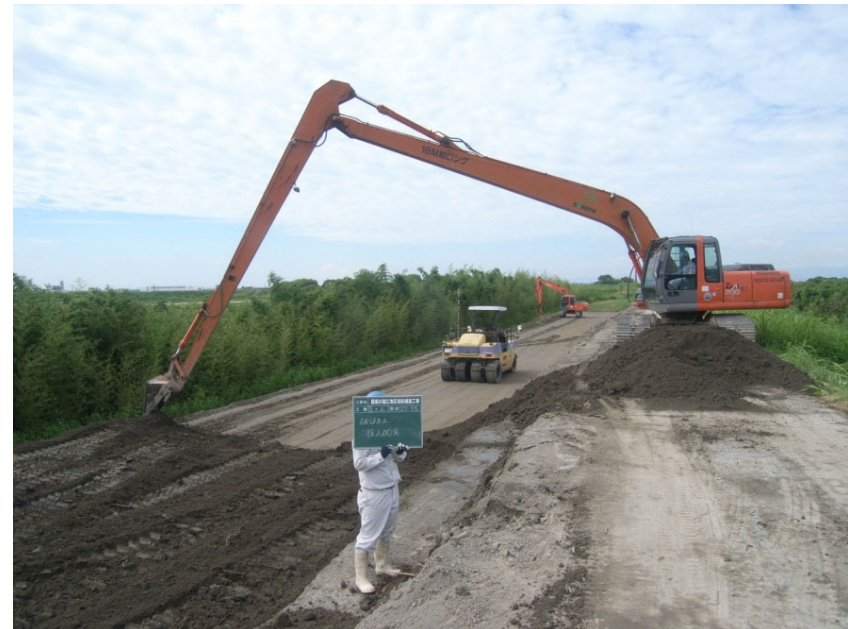
堤防強化対策工事(池ノ上地区)
