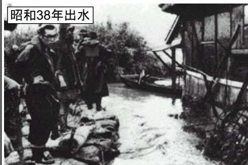
佐賀市内の浸水状況
