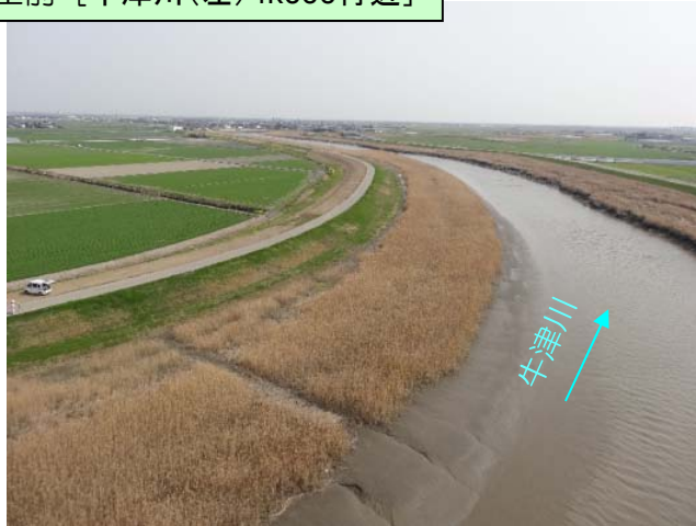
施工前 [牛津川(左)4k600付近]
