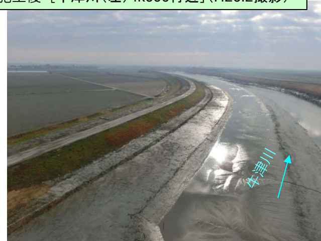
施工後 [牛津川(左)4k600付近] (H26.2撮影)
