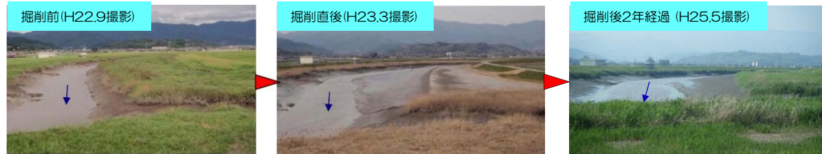
掘削前後の状況（牛津川左岸5k 800付近の掘削箇所）
