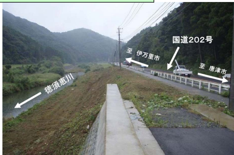
施工前〔徳須恵川6k400付近〕
