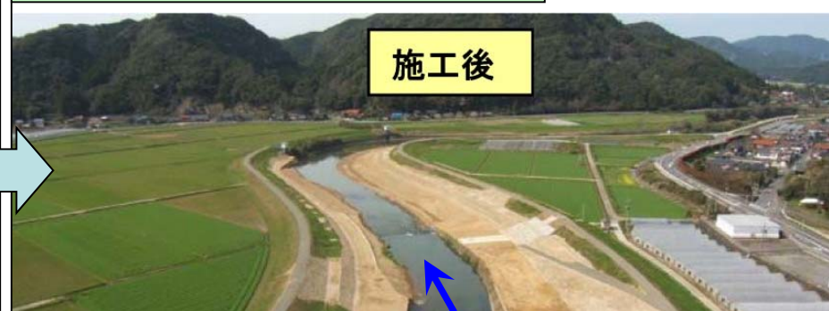
施工後 [松浦川25k000付近]
