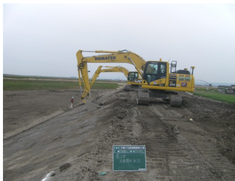
建設発生土の再利用（築堤への有効活用）
