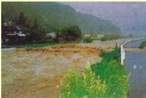
写真 1.2.6 もみのき 榎ノ木橋付近の状況
