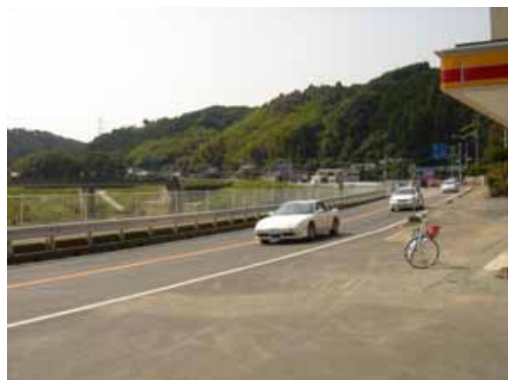
写真 1.1.37 国道 202 号 (唐津市北波多付近)
