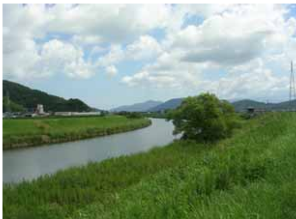
写真 2.3.34 徳須恵川下流の湛水区間
