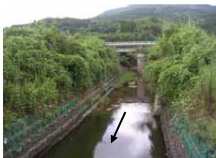
写真 2.1.2 徳須恵川上流部の 無堤区間の状況
