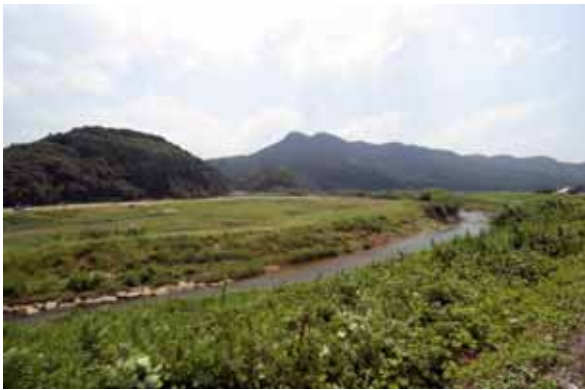
写真 2.3.16 中流部の河道状況
