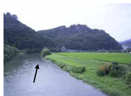
写真 2.1.3 厳木川中流部の 無堤区間の状況
