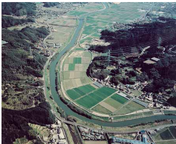
写真 2.3.32 徳須恵川下流部の状況
