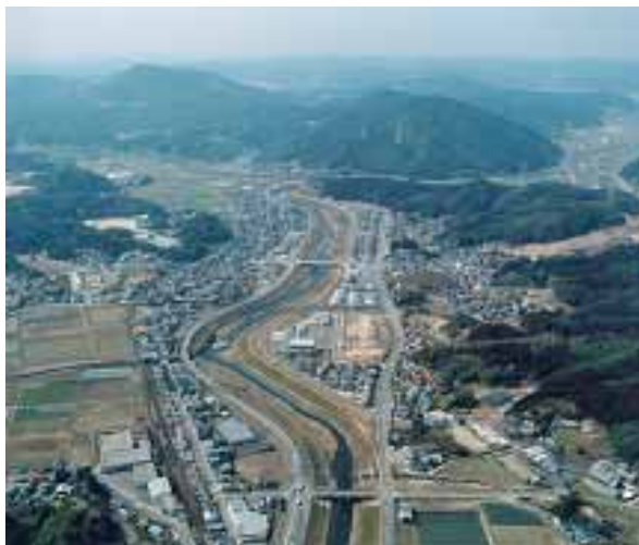
写真 2.3.38 厳木川下流部の状況
