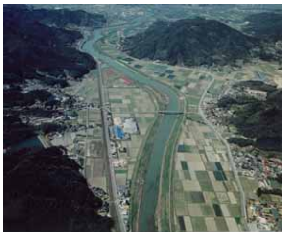
写真 2.3.20 湛水区間上流部の状況
