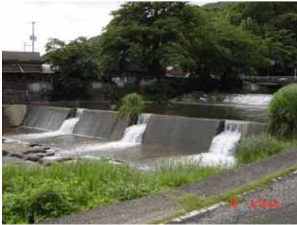
写真 2.3.50 縦断的連続性を分断した固定堰 (厳木川：立草下堰)
