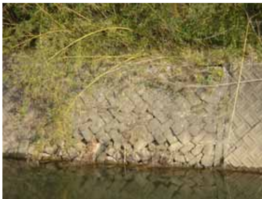
写真 2.1.5 老朽化した護岸 (松浦川 15/850 右岸付近：唐津市佐里)
