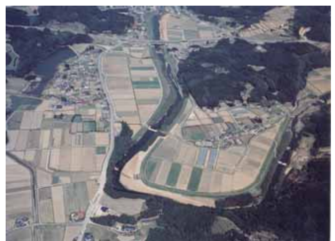
写真 2.3.2 上流部の状況（大黒井堰上流）
