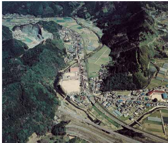
写真 2.3.39 厳木川上流部の状況
