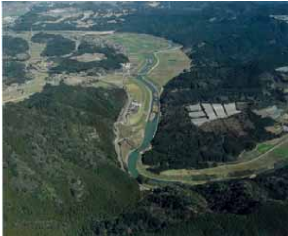
写真 2.3.14 松浦川中流部の状況
