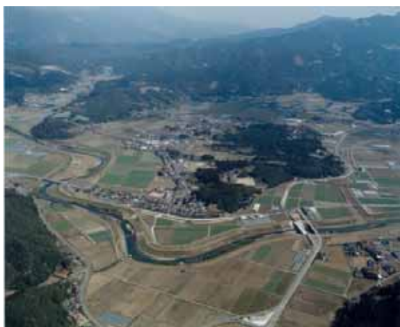
写真 2.3.1 上流部の状況（大黒井堰下流）
