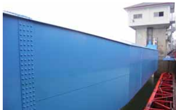
写真 4.3.7 ゲート塗装前・後(防錆対策)
