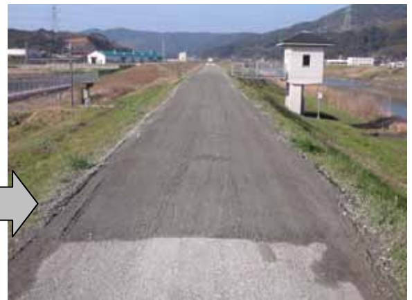
写真 4.3.5 堤防天端不陸の補修前・後
