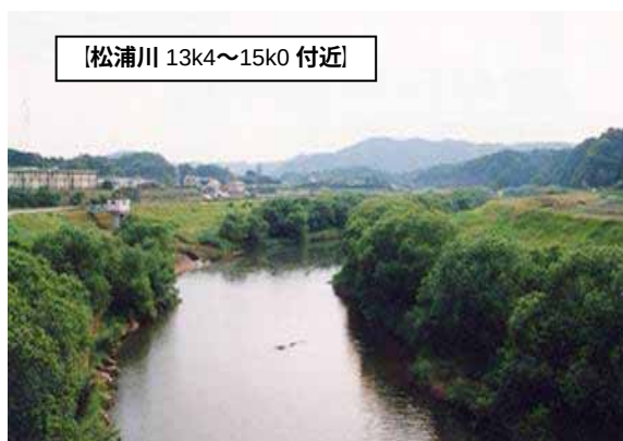
写真 4.3.2 河道内に繁茂する樹木群
