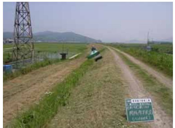
写真 4.3.4 堤防除草作業
