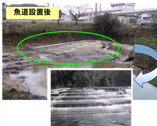
写真 4.2.12 魚道設置前後の固定堰 (厳木川厳木下堰)
