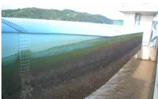
写真 4.3.7 ゲート塗装前・後(防錆対策)
