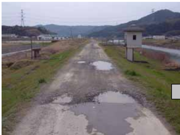
写真 4.3.5 堤防天端不陸の補修前・後
