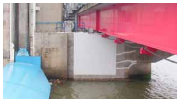
写真 4.3.6 クラックの補修前・後
