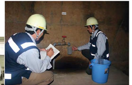
漏水計による漏水量の計測
