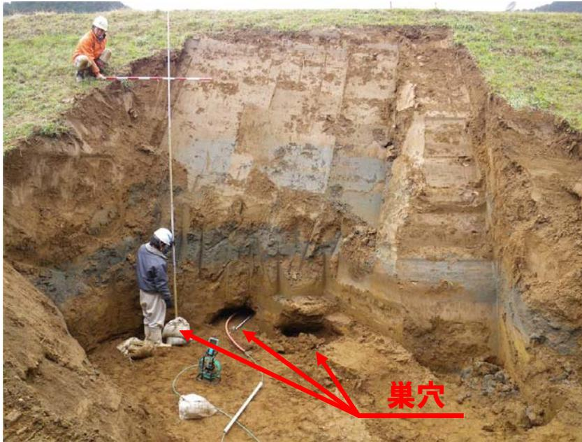
●巣穴被害により、河川堤防の機能を損ない、堤防の崩壊につながることも考えられることから、早急な復旧が必要。
