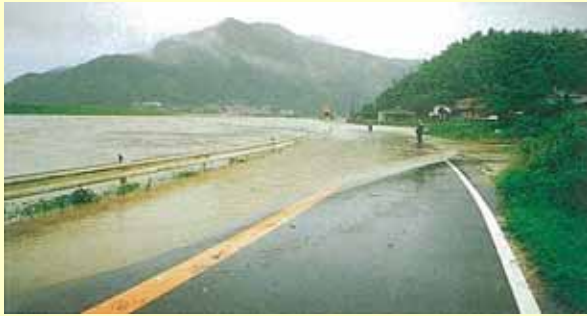
写真 1.2.4 い 伊岐佐川合流点付近の状況 (松浦川 12/600 付近：唐津市相知町)
