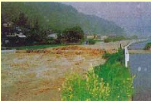
写真 1.2.6 もみのき 榎ノ木橋付近の状況 (巖木川 8/200 付近：唐津市巖木町)
