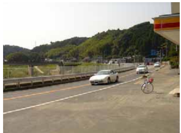
写真 1.1.37 国道 202 号 (唐津市北波多付近)
