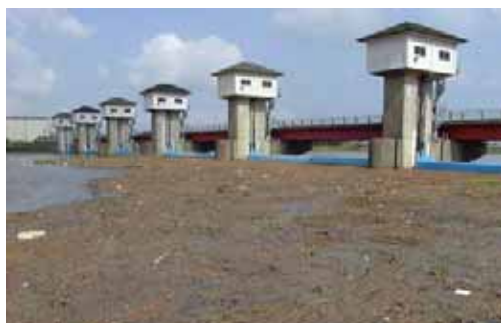
写真 2.3.67 松浦大堰に溜まった ゴミの様子
