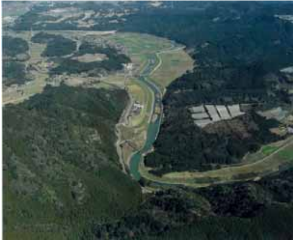
写真 2.3.14 松浦川中流部の状況
