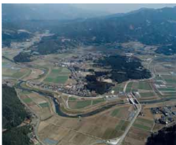
写真 2.3.1 上流部の状況（大黒井堰下流）
