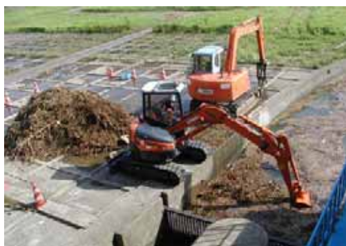
写真 2.3.69 松浦大堰に溜まった ゴミの回収作業の様子
