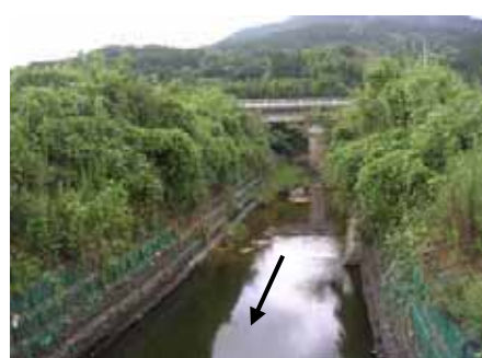
写真 2.1.2 徳須恵川上流部の無堤区間の状況
