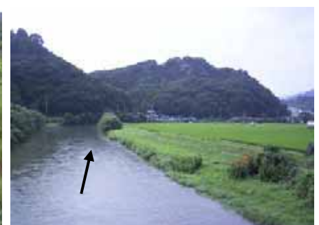
写真 2.1.3 巖木川中流部の無堤区間の状況
