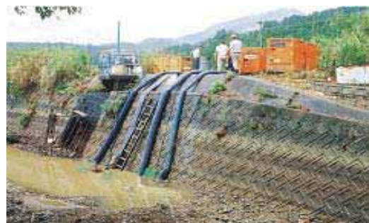
平成 6 年渇水時の状況 水位低下により樋管からの取水が困難となったため、松浦川から取水ポンプにより直接取水する住民
