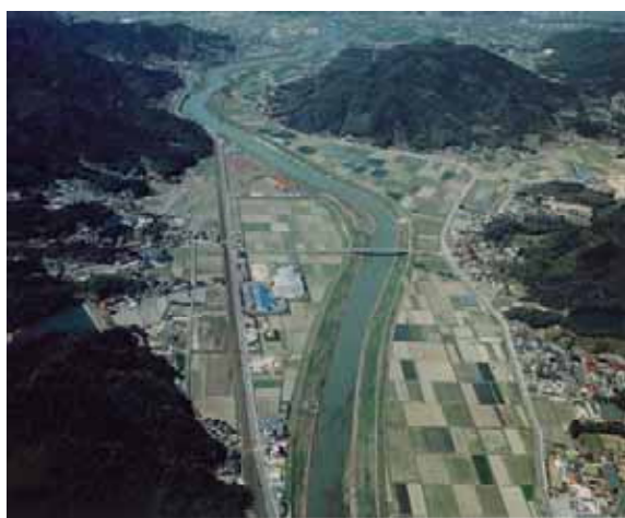
写真 2. 3. 20 湛水区間上流部の状況
