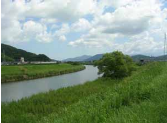
写真 2.3.34 徳須恵川下流の湛水区間
