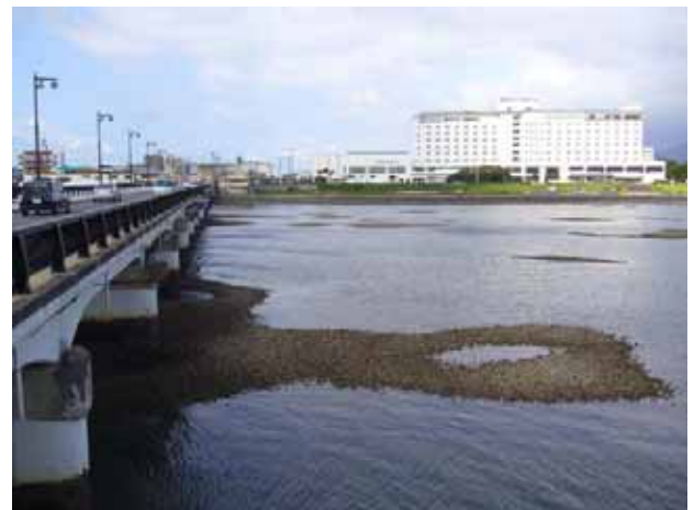
写真 2.3.56 カキ礁の状況
