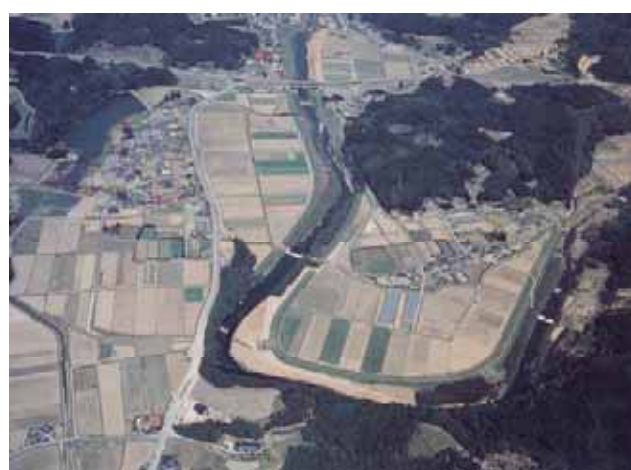
写真 2.3.2 上流部の状況（大黒井堰上流）
