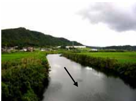
写真 2.1.1 松浦川上流部の無堤区間の状況
