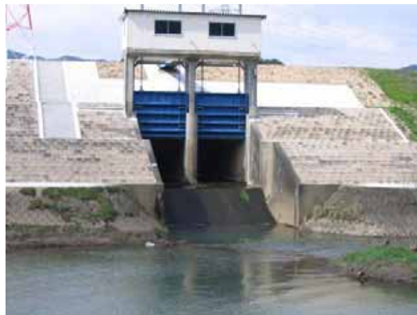
写真 2. 3. 51 横断的連続性を分断した樋門
