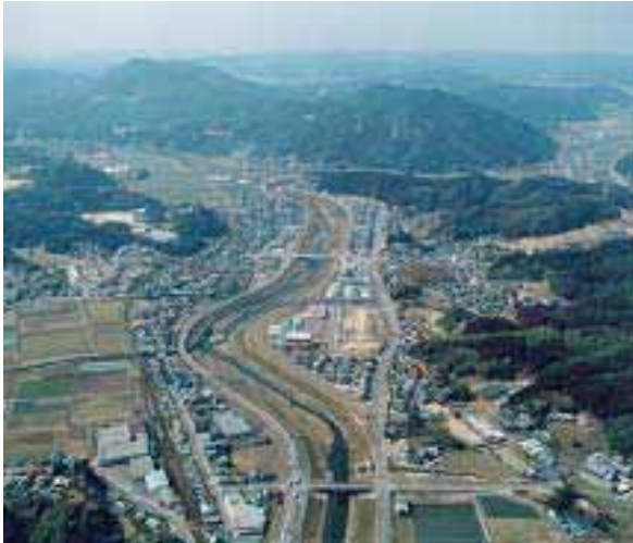
写真 2.3.38 厳木川下流部の状況
