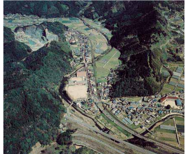
写真 2.3.39 厳木川上流部の状況
