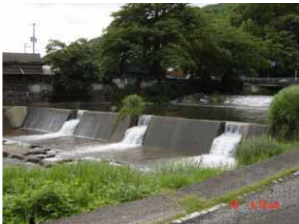
写真 2. 3. 50 縦断的連続性を分断した固定堰 (巖木川：立草下堰)
