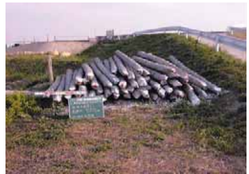
工事発生品の有効活用
