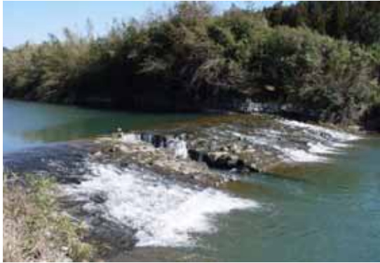
写真 4.2.27 萩の尾堰（松浦川）
