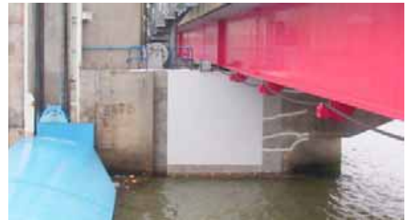
写真 4.3.6 クラックの補修前・後
