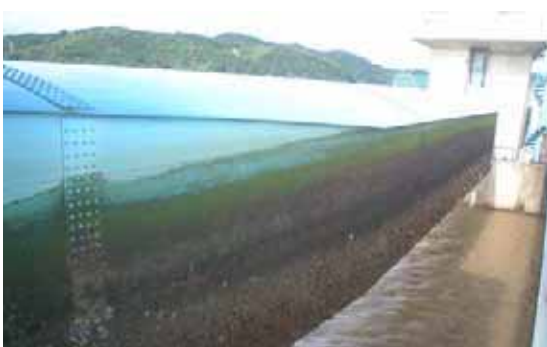
写真 4.3.7 ゲート塗装前・後(防錆対策)
