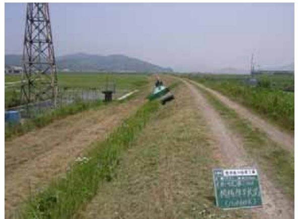
写真 4.3.4 堤防除草作業
