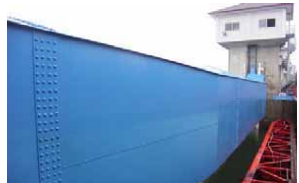
写真 4.3.7 ゲート塗装前・後(防錆対策)
