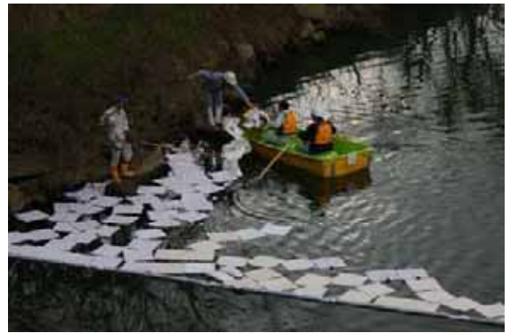
写真 4.3.16 水質事故の発生状況
