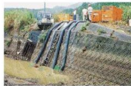
●平成6年渇水時の状況 水位低下により給管からの取水が困難となったため、松浦川から取水ポンプにより直接取水する住民
