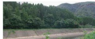
●護岸整備による河道の直線化の状況
