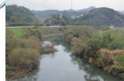
●河道内に繁茂する樹木群(松浦川)
