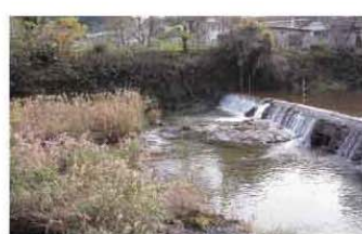
●魚道設置前の固定堰
