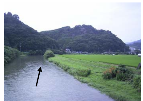
写真 2.1.3 巖木川中流部の 無堤区間の状況
