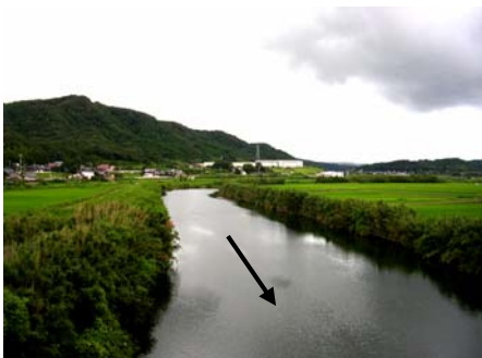
写真 2.1.1 松浦川上流部の 無堤区間の状況
