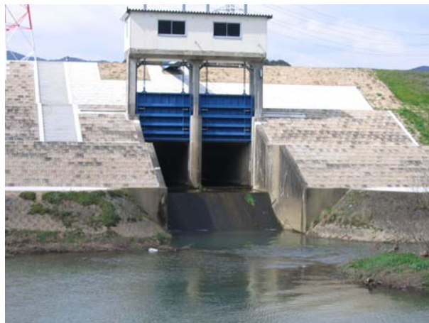
写真 2.3.53 横断的連続性を分断した樋門
