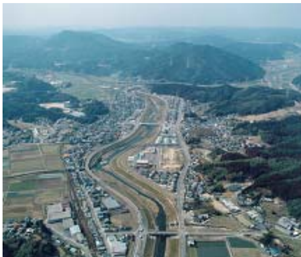
写真 2.3.39 厳木川下流部の状況
