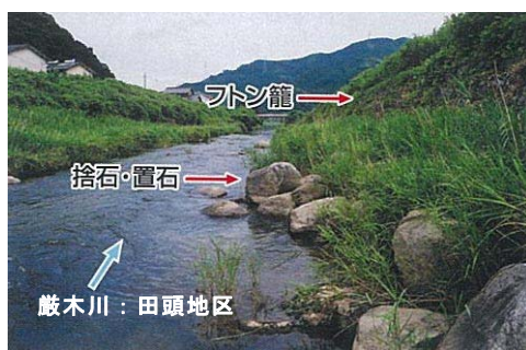
写真 2.3.51 多自然川づくりの事例
