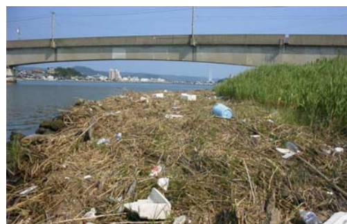
写真 2.3.70 松浦大堰下流に溜まった ゴミの様子
