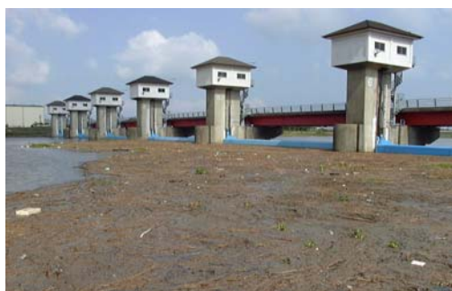
写真 2.3.69 松浦大堰に溜まった ゴミの様子
