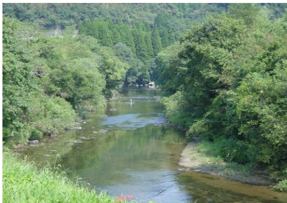
写真 2.3.8 駒鳴旧川部の河道状況
