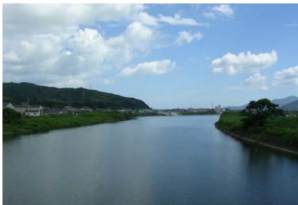
写真 2.3.22 松浦大堰湛水区間の状況
