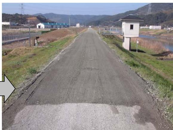
**写真 4.3.5 堤防天端不陸の補修前・後**
