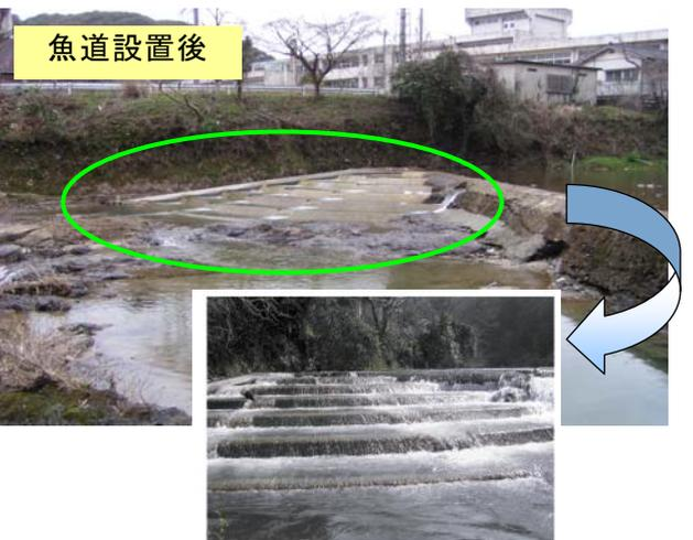
写真 4. 2. 12 魚道設置前後の固定堰 (巖木川巖木下堰)
