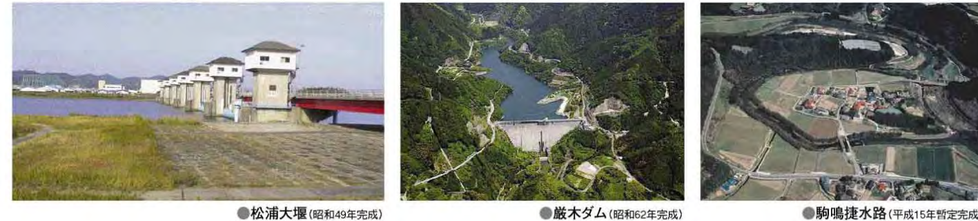
●松浦大堰(昭和49年完成) ●巖木ダム(昭和62年完成) ●駒鳴捷水路(平成15年暫定完成)
