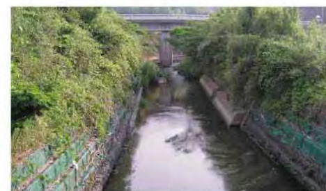
●徳須恵川上流部(河道が狭い状況)
