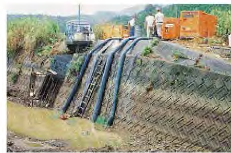
●平成6年渇水時の状況 水位低下により樋管からの取水が困難となったため、松浦川から取水ポンプにより直接取水する住民
