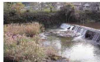
●魚道設置前の固定堰
