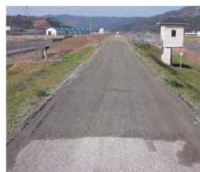
●堤防天端不陸の補修後
