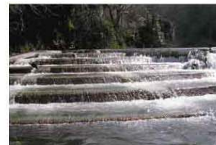
●魚道設置後の固定堰(蔵木下堰/蔵木川)
