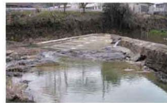
●魚道設置後の固定堰(蔵木下堰/蔵木川)
