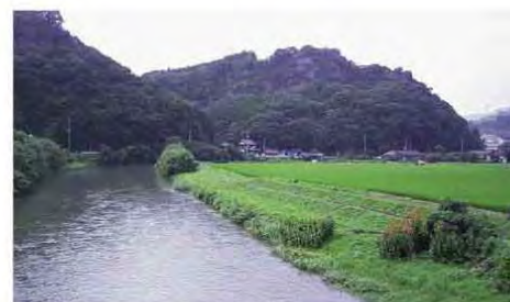
●巖木川中上流部(堤防がない状況)
