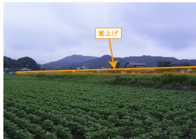
輪中堤嵩上げ整備箇所
