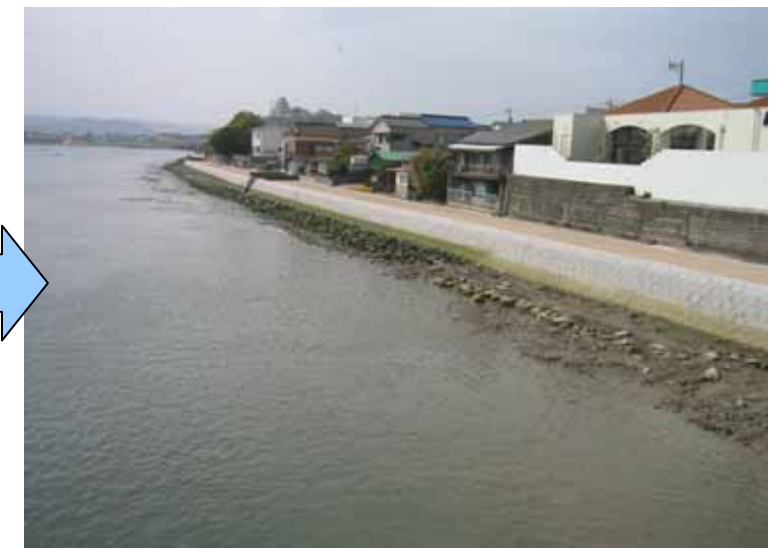
景観に配慮した護岸整備の一例（松浦川河口部）
