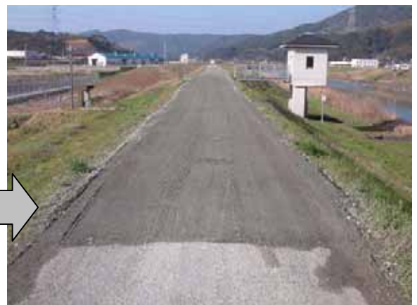
写真 4.3.5 堤防天端不陸の補修前・後
