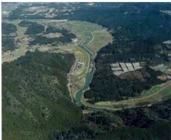
写真 2.3.14 松浦川中流部の状況 (松浦川 18/000 付近：唐津市相知町) 狭い田園地帯を蛇行しながら流下しています。
