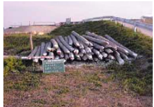
工事発生品の有効活用
