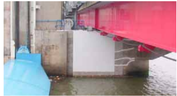
写真 4.3.6 クラックの補修前・後
