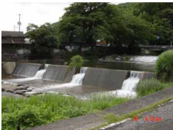
写真 2.3.52 縦断的連続性を分断した固定堰 (巖木川：立草下堰)
