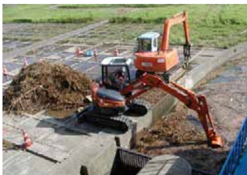
写真 2.3.72 松浦大堰に溜まった ゴミの回収作業の様子
