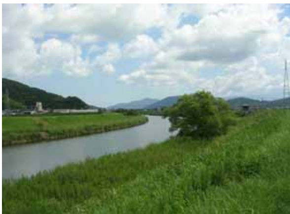
写真 2. 3. 34 徳須恵川下流の湛水区間
