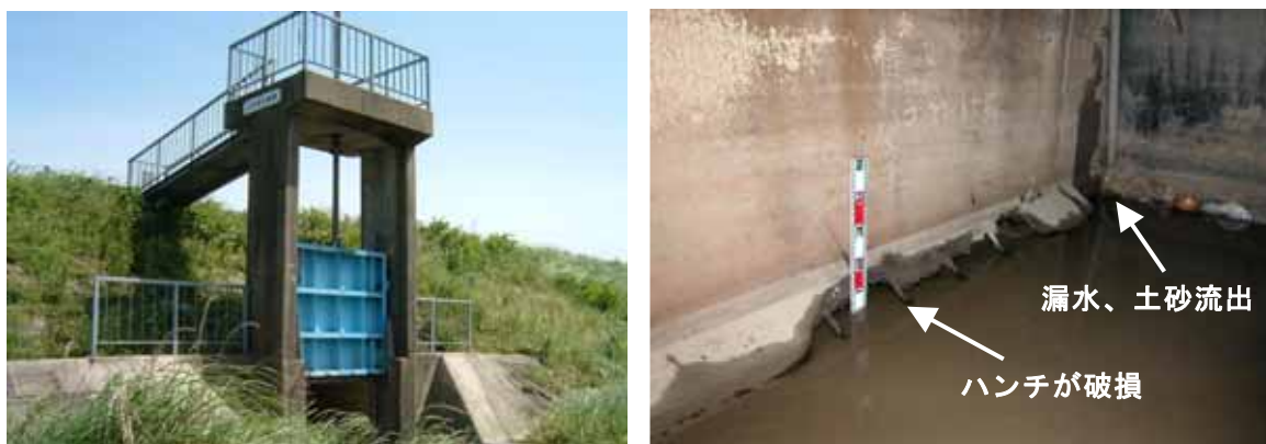
写真 2.1.7 老朽化した樋管 (徳須恵川 0/045 右岸付近：唐津市石志)
