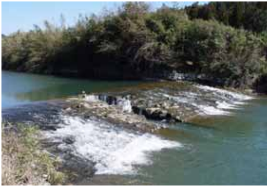
写真 4.2.27 萩の尾堰（松浦川）
