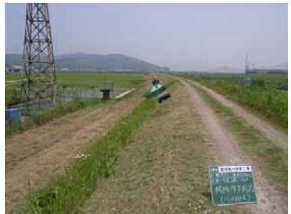
写真 4.3.4 堤防除草作業
