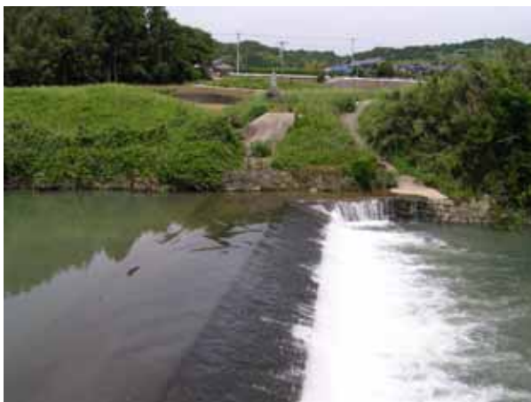
写真 1.1.19 馬ノ頭へ続く水路 (松浦川) (松浦川 30/000 付近：伊万里市松浦町)
