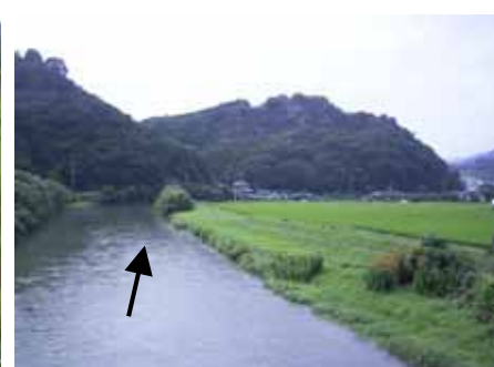
写真 2.1.3 巖木川中流部の 無堤区間の状況
