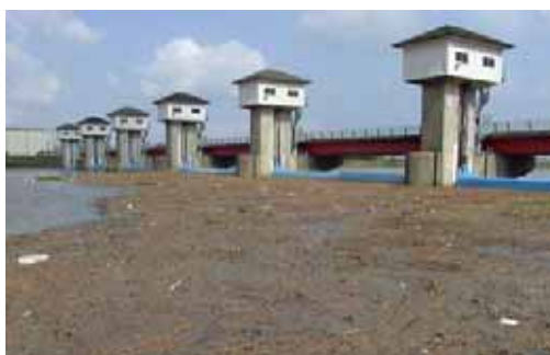
写真 2.3.70 松浦大堰に溜まった ゴミの様子
