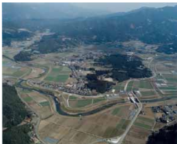
写真 2.3.1 上流部の状況（大黒井堰下流）
