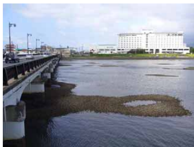
写真 2.3.59 カキ礁の状況
