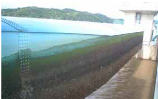
写真 4.3.7 ゲート塗装前・後(防錆対策)
