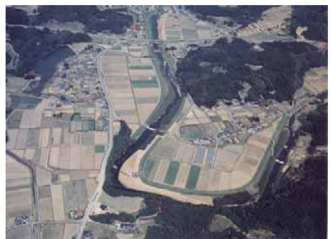
写真 2.3.2 上流部の状況（大黒井堰上流）
