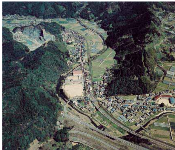
写真 2.3.40 厳木川上流部の状況
