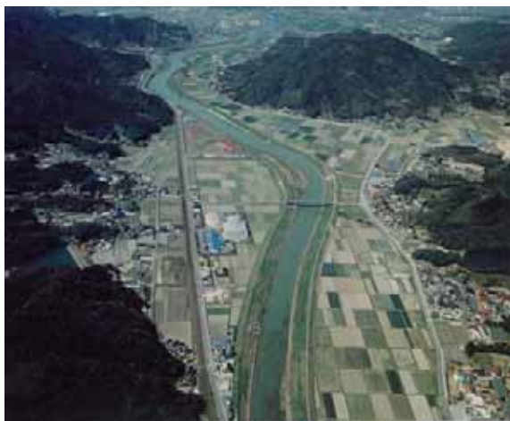
写真 2. 3. 20 湛水区間上流部の状況
