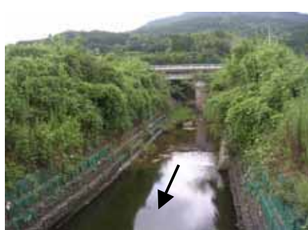
写真 2.1.2 徳須恵川上流部の 無堤区間の状況
