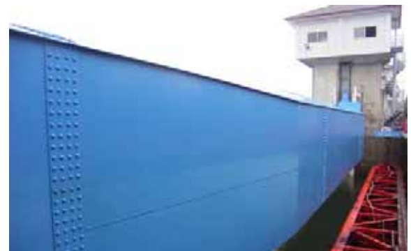
写真 4.3.7 ゲート塗装前・後(防錆対策)
