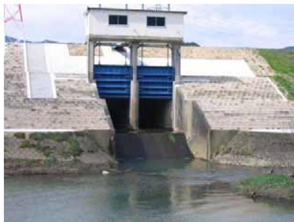
写真 2.3.53 横断的連続性を分断した樋門
