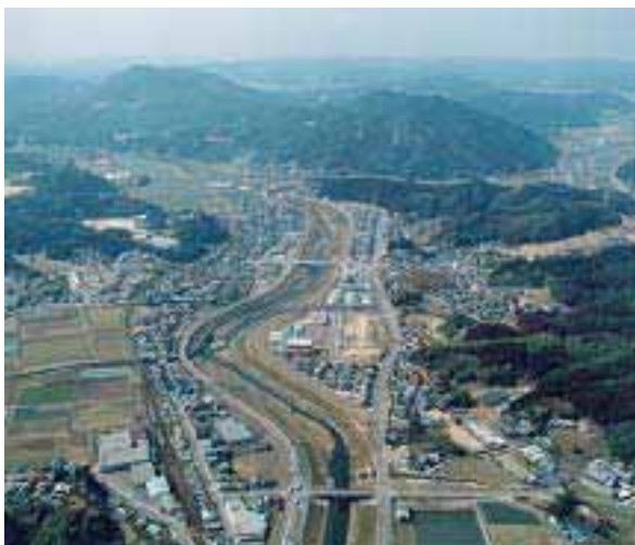
写真 2.3.39 厳木川下流部の状況
