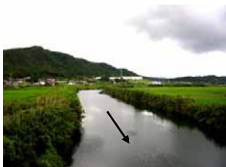
写真 2.1.1 松浦川上流部の 無堤区間の状況
