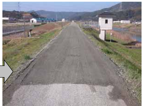
写真 4.3.5 堤防天端不陸の補修前・後
