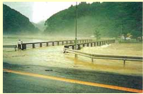
写真 1. 2. 7 志気橋付近の状況
