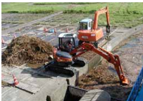
写真 2.3.71 松浦大堰に溜まった ゴミの回収作業の様子
