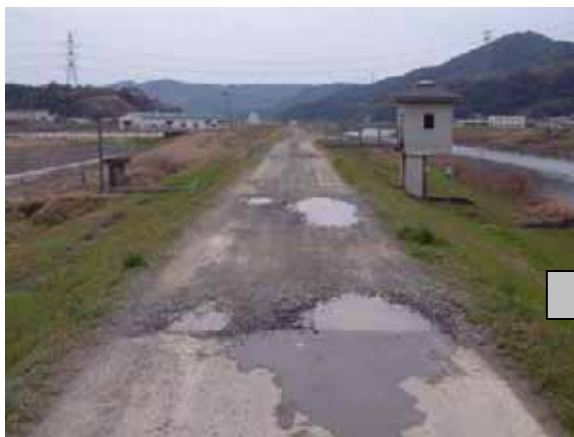
写真 4.3.5 堤防天端不陸の補修前・後
