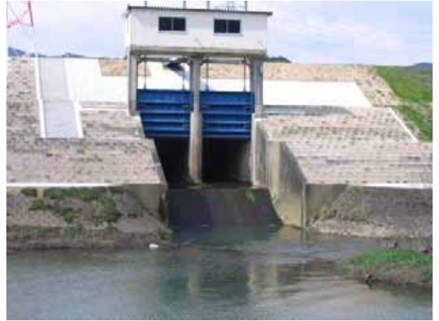
写真 2. 3. 53 横断的連続性を分断した樋門
