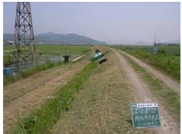
写真 4.3.4 堤防除草作業
