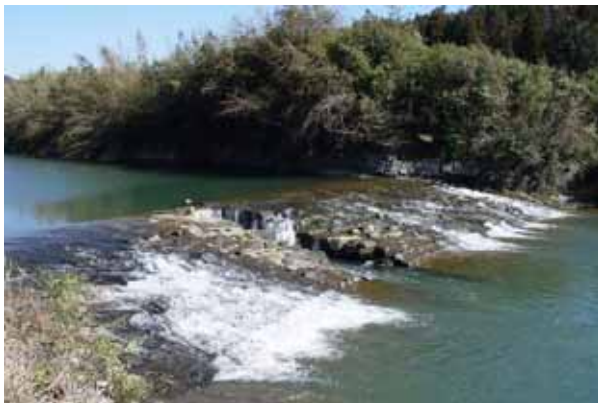
写真 1.1.18 萩の尾堰 (松浦川) (松浦川 31/400 付近：武雄市若木町)
