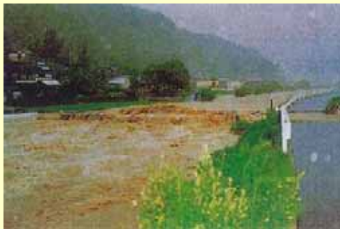
写真 1. 2. 6 榎ノ木橋付近の状況
