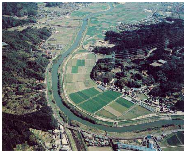
写真 2.3.32 徳須恵川下流部の状況 (徳須恵川 2/000~4/000 付近: 唐津市千々賀・石志) 低山に囲まれた上流部を抜け、緩やかに蛇行しながら流下します。
