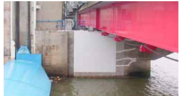
写真 4.3.6 クラックの補修前・後
