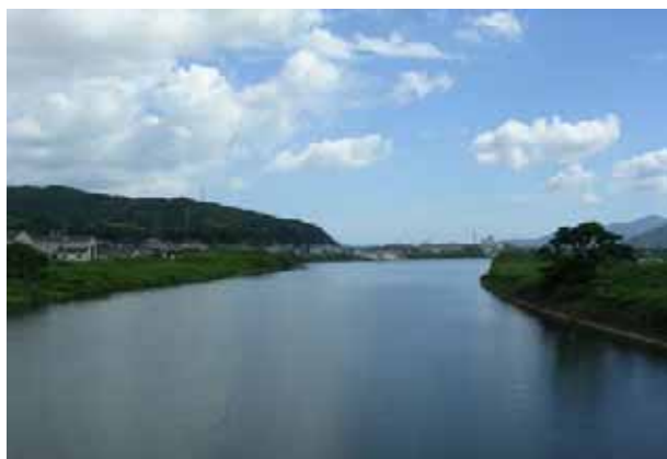
写真 2.3.22 松浦大堰湛水区間の状況
