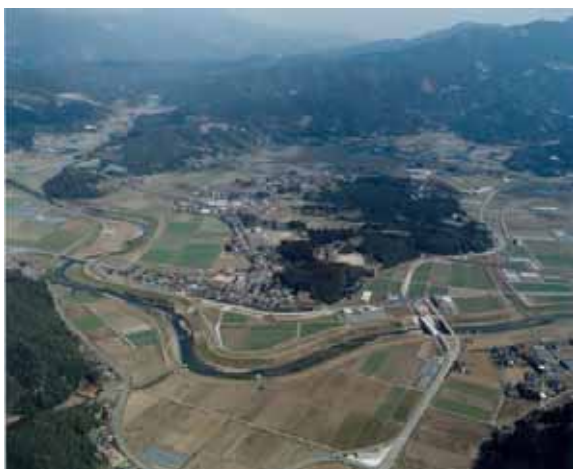
写真 2.3.1 上流部の状況（大黒井堰下流）
