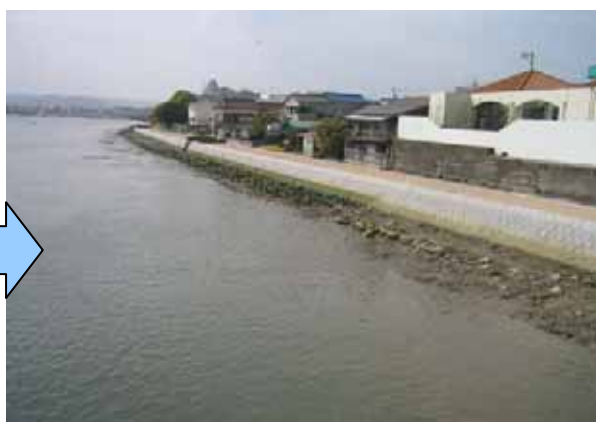
写真 4.2.26 景観に配慮した護岸整備の一例
