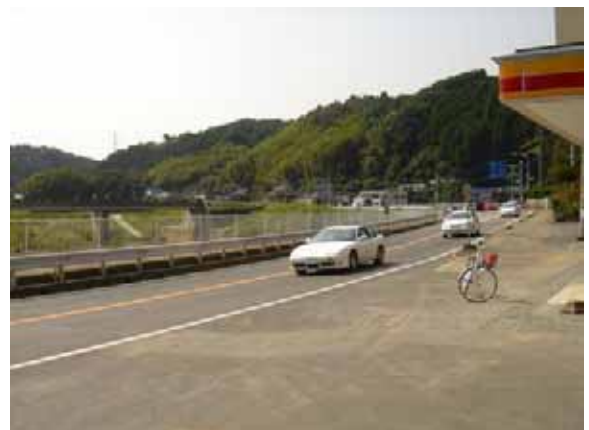
写真 1. 1. 37 国道 202 号 (唐津市北波多付近)
