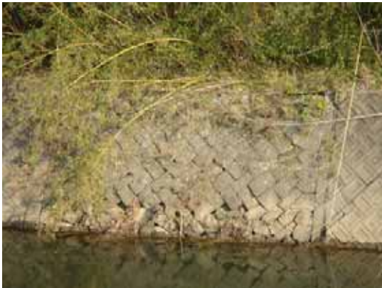
写真 2.1.5 老朽化した護岸 (松浦川 15/850 右岸付近：唐津市佐里)
