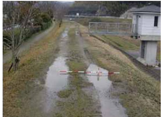
写真 2.1.6 天端部の不陸の状況 (厳木川 0/400 左岸付近：唐津市厳木町)
