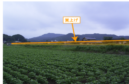
輪中堤嵩上げ整備箇所
