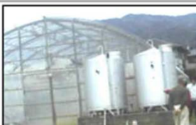
ビニールハウスのボイラーが破損し重油流出
