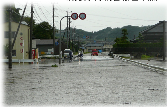
道路冠水(武雄市橋町片白地区)六角川27k右岸
