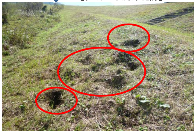
【松浦川中流部堤防】
