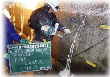
ひび割れ内部へ注入材を充填し、耐久性の向上を図っています
