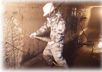
劣化箇所の一帯をはつた後、モルタルで補修します
