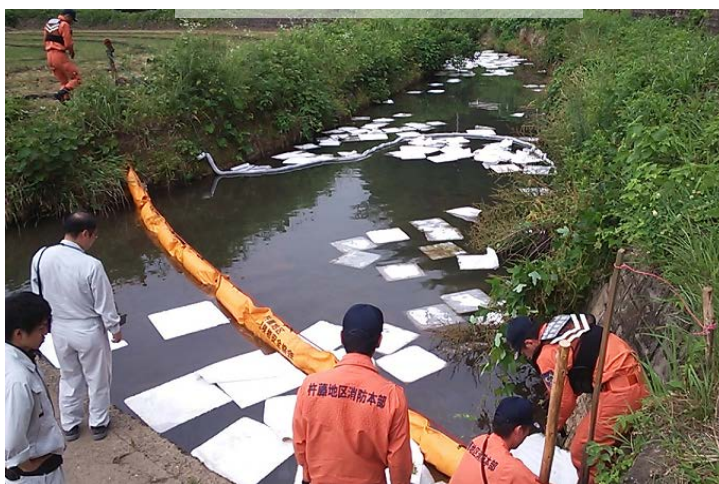
油の回収状況 (オイルフェンス・吸着マット設置)
