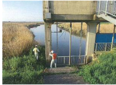
明るくなってから詳細点検 (ひび割れ、変形など異常の有無を調査)
