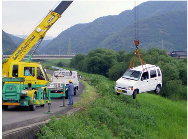
転落車両の引き上げ作業
