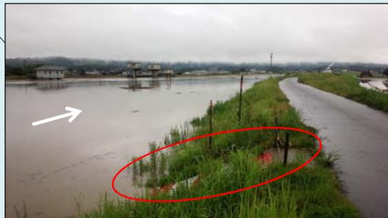
水位標を確認し、堤防越水までの余裕を確認しています。(赤と白の高さの間隔は20cm)
