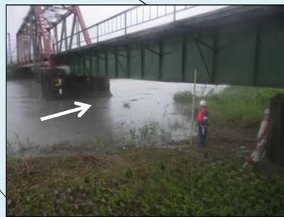
鉄道橋の橋桁までの余裕を随時計測しています。
