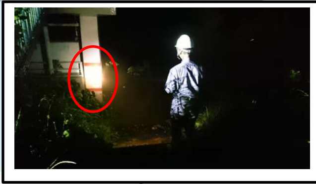
排水樋門の門柱に設置された水位危険度レベルを確認しています。
