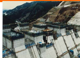
昭和60年3月頃 ダム本体コンクリート打設状況
