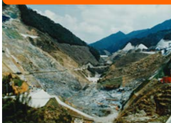
昭和58年7月頃 ダム本体基礎掘削状況
