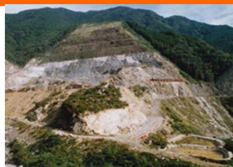
昭和58年10月頃 原石山掘削状況
