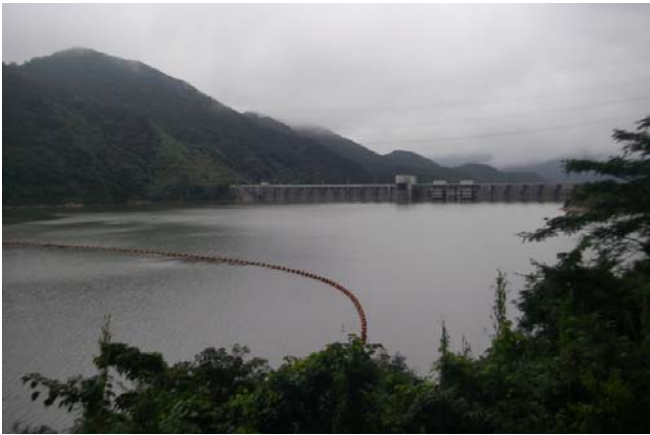
ダム右岸側より
