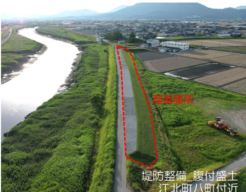
堤防補強 法尻ブロック 医王寺橋付近
