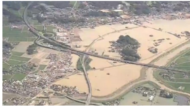
武雄市付近の浸水状況(令和3年8月)
