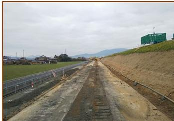
堤防の厚みを確保するための前段として、土を盛るところの基礎地盤を改良しています。
