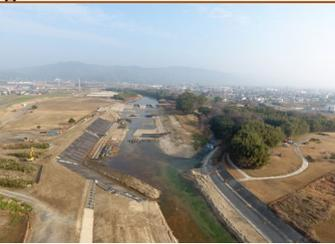
川の中に溜まった土砂を撤去し、水の流れを良くしています。
