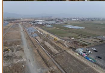
想定外の洪水にも備えて、万が一堤防を水が超えても壊れにくいように堤防を補強しています。
